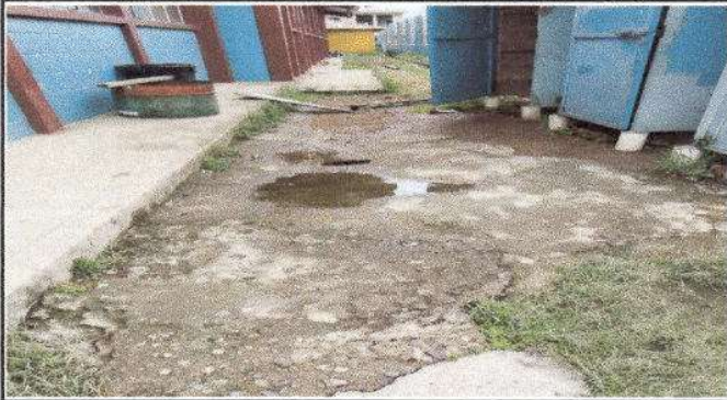
Foto 1: Sustitución de piso de torta de concreto
