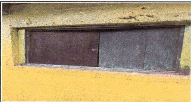
Foto 5: Sustitución de ventana de madera por ventana de metal
