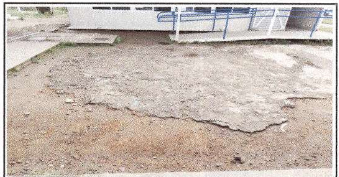
Foto 6: Sustitución de piso de torta de concreto
