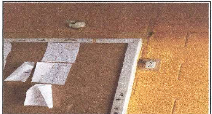
Foto 4: Sustitución de lámparas tipo Led
